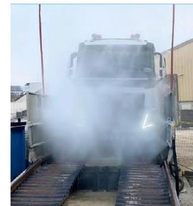
Conditionnement des déchets en bennes équipés de conteneur bag et décontamiation avec passage sous portique et laveur de roue.
