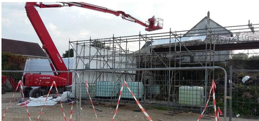
Structure d'échafaudage lestée avec thermobâchage en cours de montage
