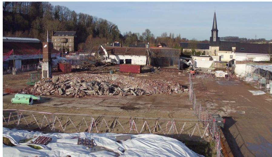
Travaux de conditionnement effectué sous brumisation (pelle équipé de rampe) et à l'aide de canon de brumisation
